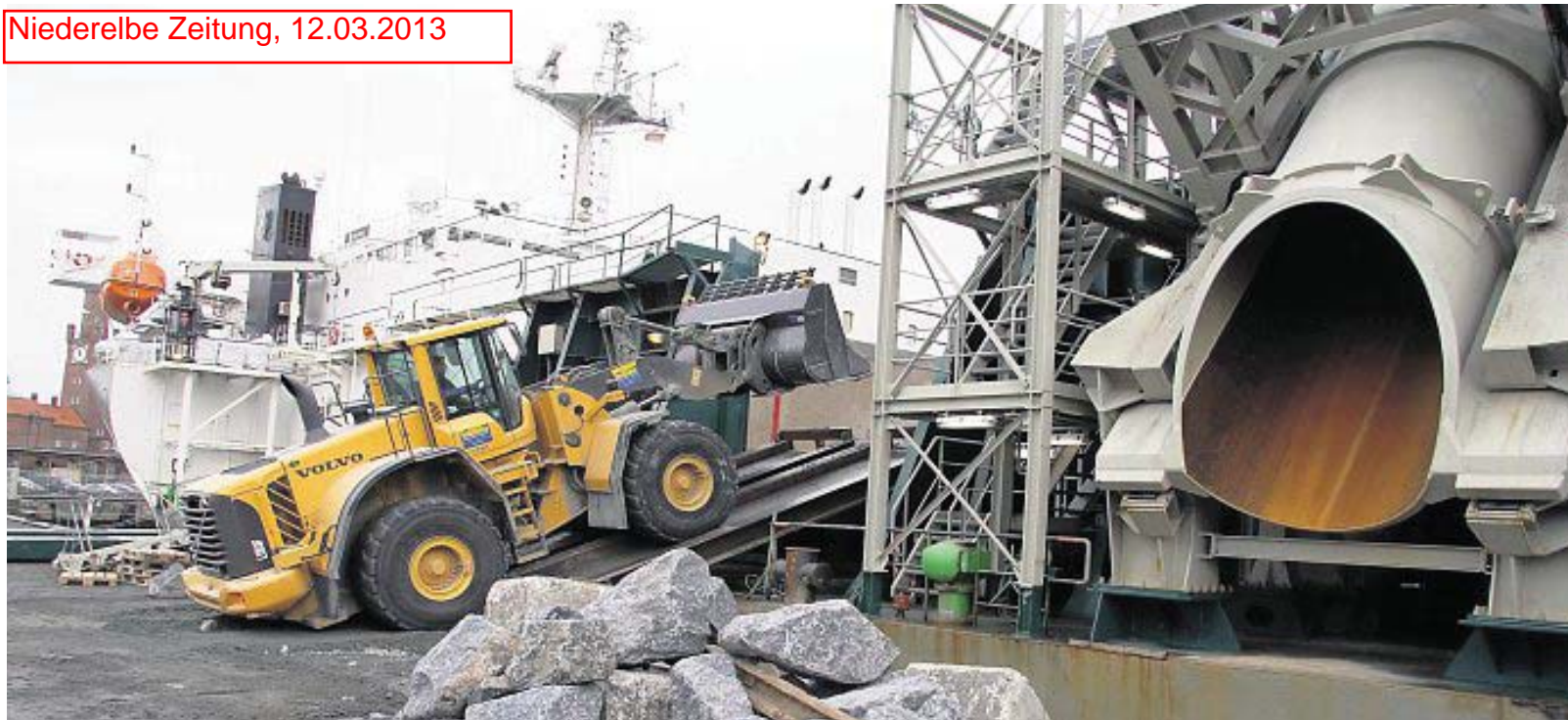
Drei Radlader „schaufelten“ am Freitag und Sonnabend die schweren Granitfelsbrocken über Rampen in den Bauch des Spezialschiffes . Die „Seahorse“ ist mit einem Fallrohr (siehe Foto) ausgerüstet, über das die Steine unter Wasser am Fuß der Windkraftfundamente (Monopiles) positioniert werden können. Fotos: Sasssen
